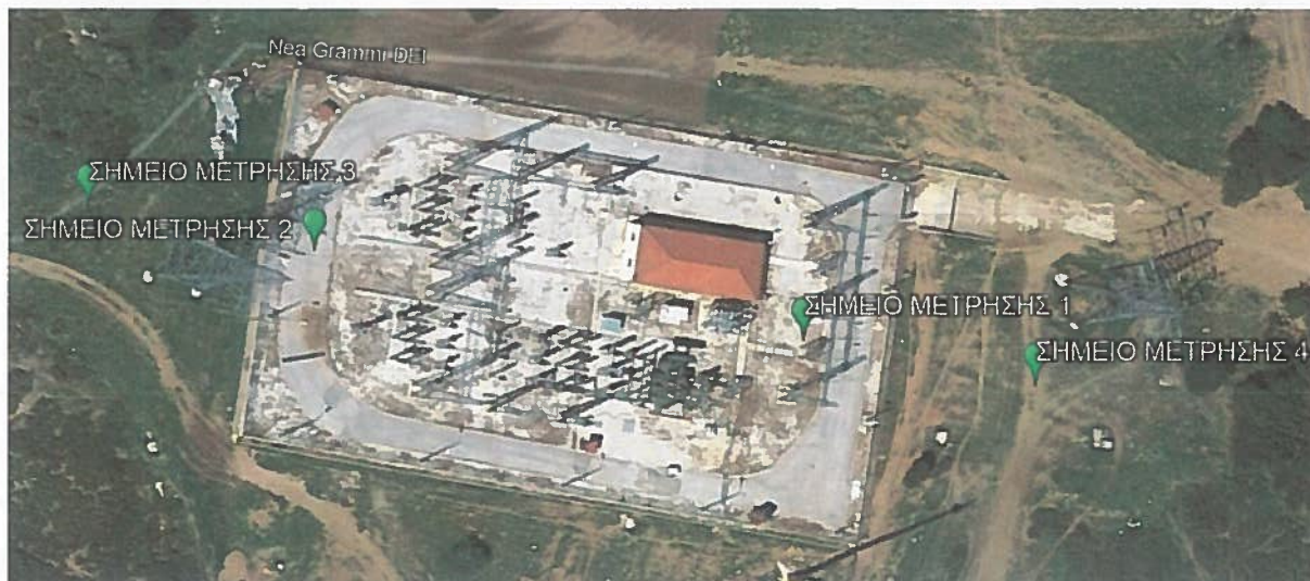
Φωτογραφία 2: Δορυφορική φωτογραφία του Υποσταθμού (από την εφαρμογή Google Earth), στη θέση “Μπάλα”, στο Παναχαϊκό Όρος.
